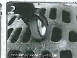
2. Au sol, certaines plaques de recouvrement ne sont pas correctes mises aux normes. La plaque photographiée se situe sur le trottoir dans l'axe d'une traversée piétonne, malgré sa faible largeur de fente, 3 cm contre 2 cm autorisés, le risque de blocage de roue (ou caniveaux) est réel.
