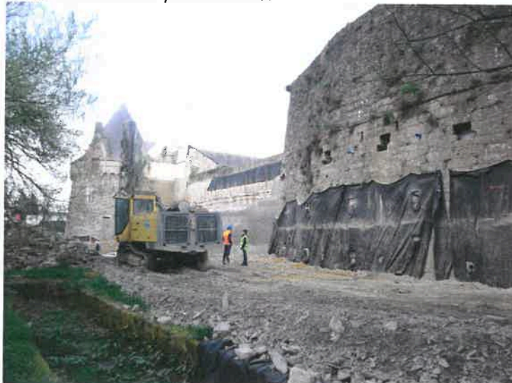
Réalisation des clous sur le dernier rang inférieur et injection encours. Réalisation de l'ensemble des drains sur le bastion-Sud-Est.
