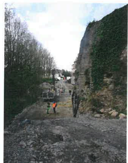
Réalisation des clous sur le dernier rang inférieur et injection encours. Réalisation de l'ensemble des drains sur le bastion-Sud-Est.
