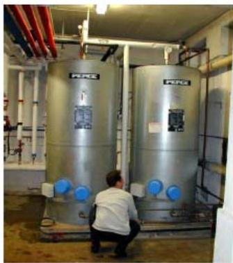
Les arrivées d'eau disposent de manomètres et de robinets pour pouvoir facilement tester les pressions.
