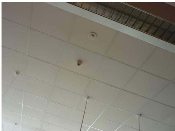
Dans les salles de cours et les dortoirs, un détecteur de lumière au plafond adapte l'intensité lumineuse aux conditions d'éclairage du soleil. Un système d'interrupteurs est tout de même conservé pour garder le réflexe d'allumage/extinction.
