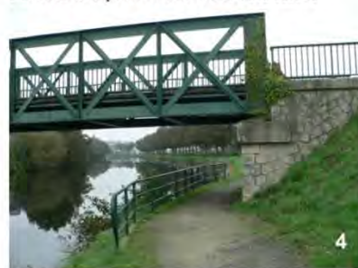
Pont métallique de l'ancienne voie ferrée
