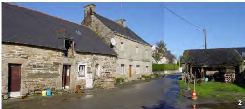
02 : Dans les villages, ici à Stival, fermes et maisons sont souvent construites à l'alignement des anciens chemins. Les dépendances, remises et granges sont parfois situées de l'autre côté de la voie.
