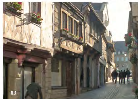
03 : rue du Pont, comme rue du Fil, les alignements de maisons à façades en pan de bois (16 e - 17 e siècles) forment un ensemble urbain remarquable. Les encorbellements confèrent à ces rues étroites un profil caractéristique.
