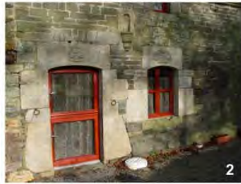
02 : Talcoët-Noyal, maison à pièce unique datée 1758 ; façade soignée ornée d'une niche à Vierge et de linteaux sculptés
