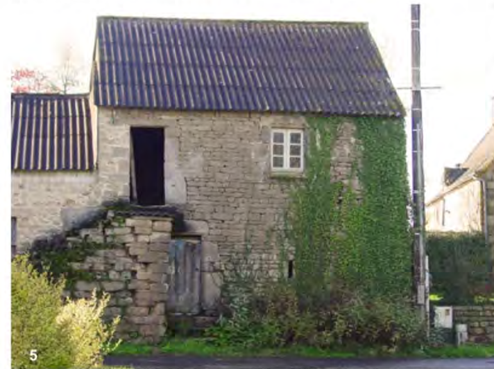
05 : Sainte-Tréphine, maison à étage et escalier extérieur début 17 e siècle. La souche de cheminée en pignon nord (à droite) a disparu. La pièce du RDC éclairée d'un simple jour en façade pourrait être un cellier ou une étable. A noter la qualité de l'appareil des parements.
