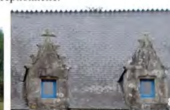
07 : La Houssaye, maison couverte en roseau. 08 : Manoir de la Villeneuve, couverture d'ardoise, faitage à ligolet d'ardoises.
