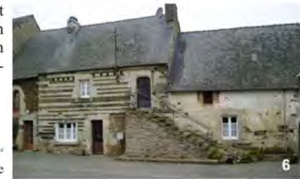
06 : Stival, ferme du 17 e siècle, la distribution de l'étage est assurée par un escalier extérieur, adossé à la façade du logis et de l'étable (© ville de Pontivy).
