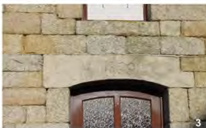
01: Ferme à Stival, parement en pierre de taille avec alternance d'assises de granite et de schiste. 03 : Ste-Tréphine, maison datée 1820, façade en pierre de taille de granite.
