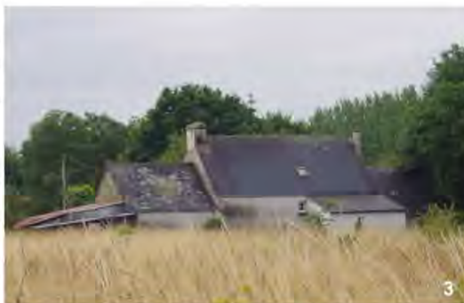
03 : Ferme isolée au sud de l'écart de Guernal : perpendiculaire à la route, la façade principale est orientée au sud-est, tandis qu'au nord contre une façade postérieure quasi aveugle, est adossé un appentis postérieur servant probablement de cellier.
