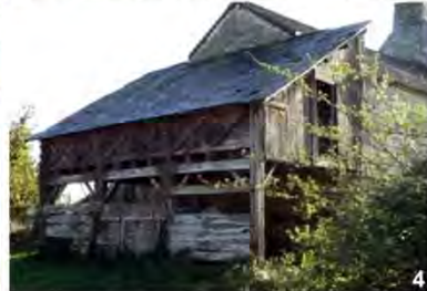
02: Coët-Stival, parement en moellons tout-venant de granite recouvert d'un enduit. 04 : Sainte-Tréphine, grange-remise en charpente dont le niveau supérieur est en pan de bois.
