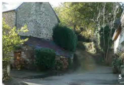
04 : Sainte-Tréphine, remarquable mur de soutènement appareillé en moellons de granite, bordant le chemin nord vers la route de l'Echantillon.
