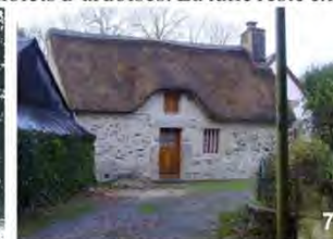
07 : La Houssaye, maison couverte en roseau. 08 : Manoir de la Villeneuve, couverture d'ardoise, faitage à ligolet d'ardoises.
