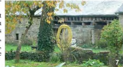
04 : Talcoët-Noyal, exemple de grange-remise sur poteaux de granite.
