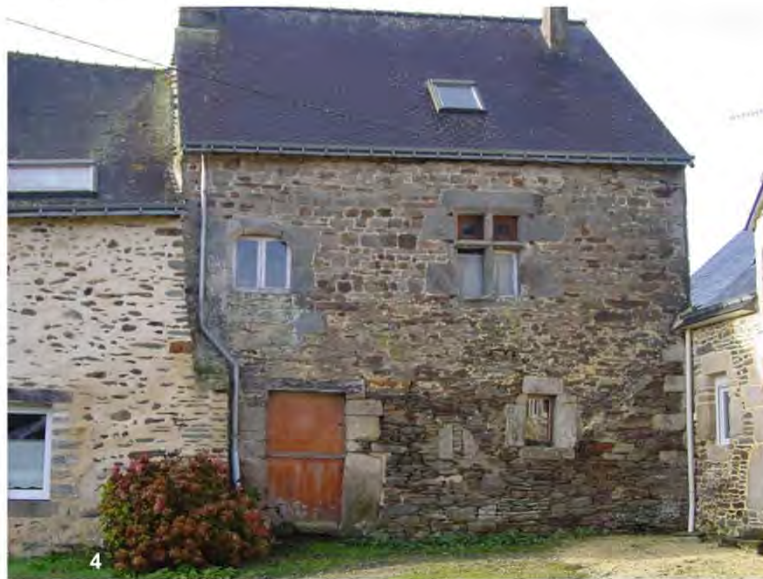
04 : Saint-Niel, maison à étage dont l'escalier extérieur a disparu ; de fait la porte haute est réduite en une fenêtre. La pièce de l'étage est éclairée d'une grande fenêtre à meneaux reposant sur appui saillant (16 e siècle), protégée à l'origine d'une grille de défense.
